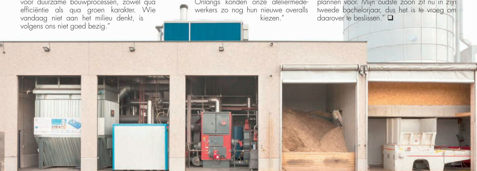
Met deze ORC- of Organic Rankine Cycle-installatie wordt het houtafval van de schrijnwerkerij omgezet in warmte en elektriciteit voor het bedrijf (foto © Liesbet Goetschalckx)
